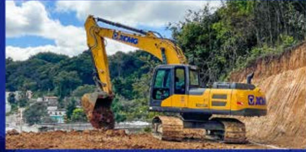
Construcción del CAIMI Centro de Atención Integral Materno Infantil.
